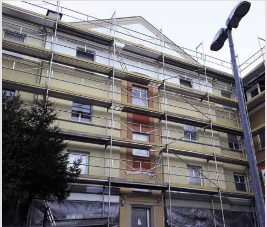
Immer häufiger verdeutlichen nach 2011 Gerüste die Sanierungstätigkeit der ABG.
