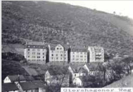
1912 erbaute Wohnhäuser der AgBG am Gierchagener Weg.
