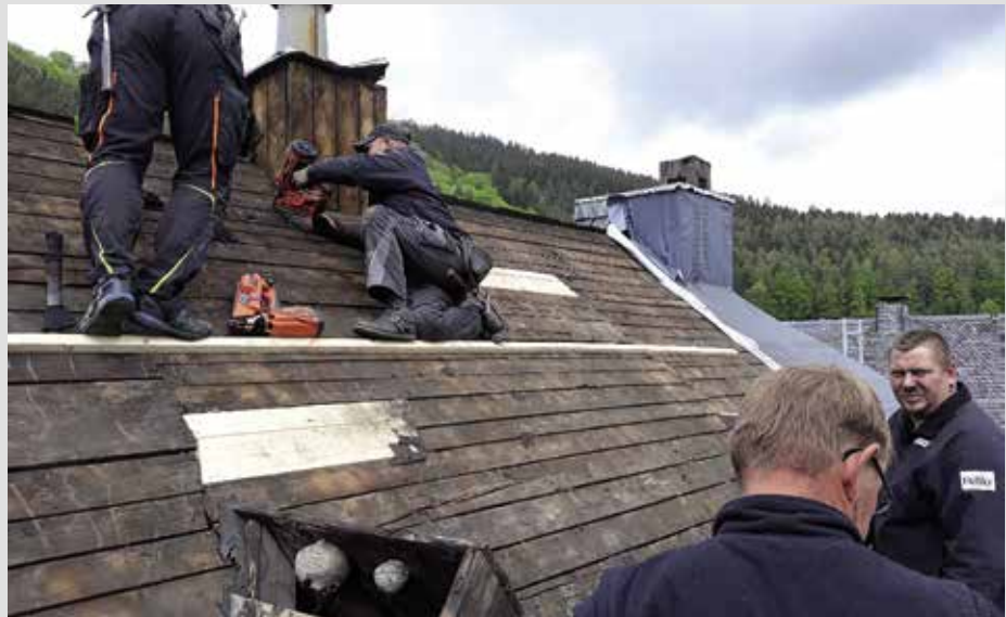
Dacheindeckungsarbeiten in der denkmalgeschützten Ackerstraße 2019.
