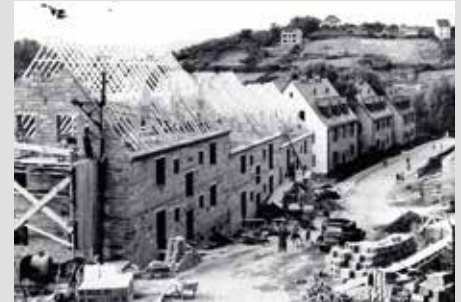
Blick auf die entstehenden AgBG-Häuser Wilhelmstraße 42-46.
