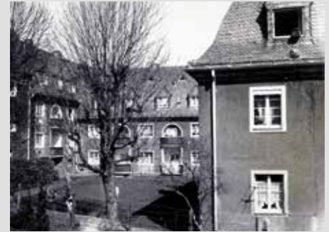
Blick in den Innenhof der nach 1923 erbauten AgBG-Häuser in der Ackerstraße.
